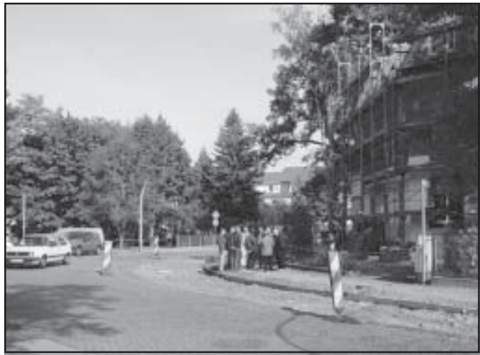
Bauarbeiten auf der L401
