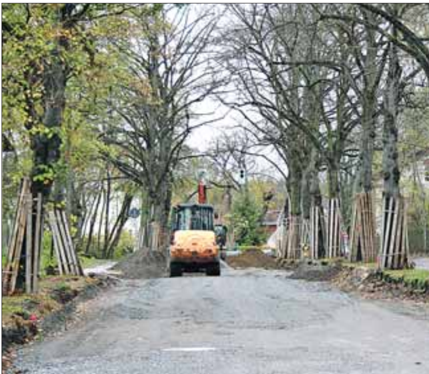
Die Bagger ziehen im Bereich der Dorfstraße in den südlichen Anger weiter.
