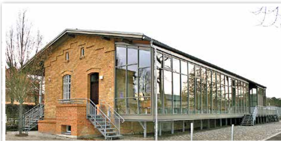
Das neue Bürgerhaus direkt am S-Bahnhof Zeuthen ist ein weiterer Meilenstein in der Entwicklung von Zeuthen zu einem attraktiven Standort.
