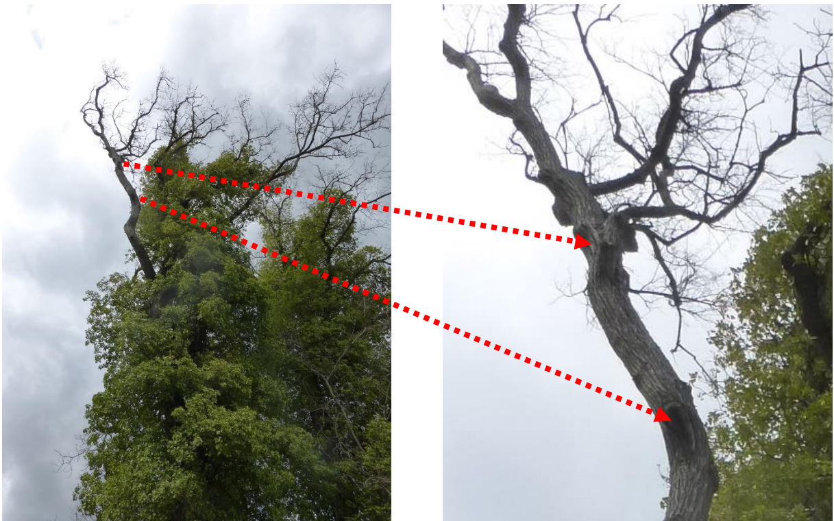
Abb. 27 und 28: Astungswunden z.T. mit Morschung in der Krone sowie auskragende Äste.
