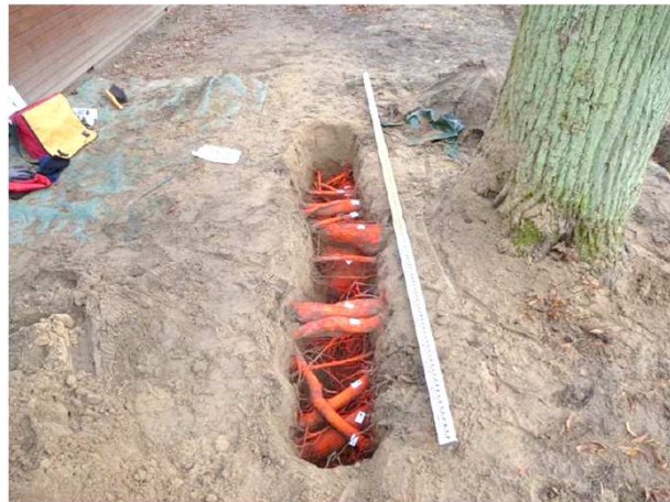
Suchschachtungen im Bereich Gehweg/ Zufahrt
