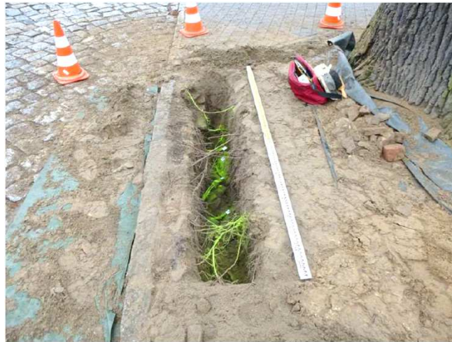
Suchschachtungen im Bereich Fahrbahnrand
