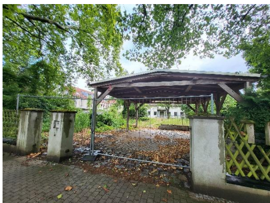
Abb. 3: Wohngebäude im Ergänzungsbereich 13
