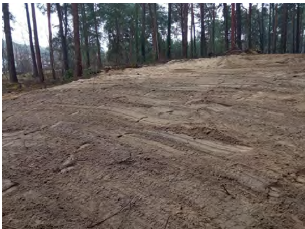
Rückbaufläche des Wasserwerks und der Zisterne
