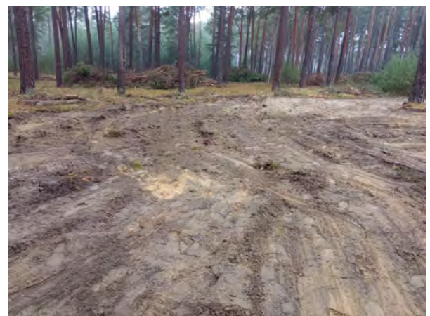
Fläche Brunnen 2 nach Rückbau
