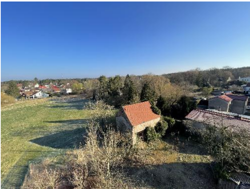
Abbildung 5: Blick auf ehem. Scheune auf Flurstück 112, Bild vom 19.03.2024
