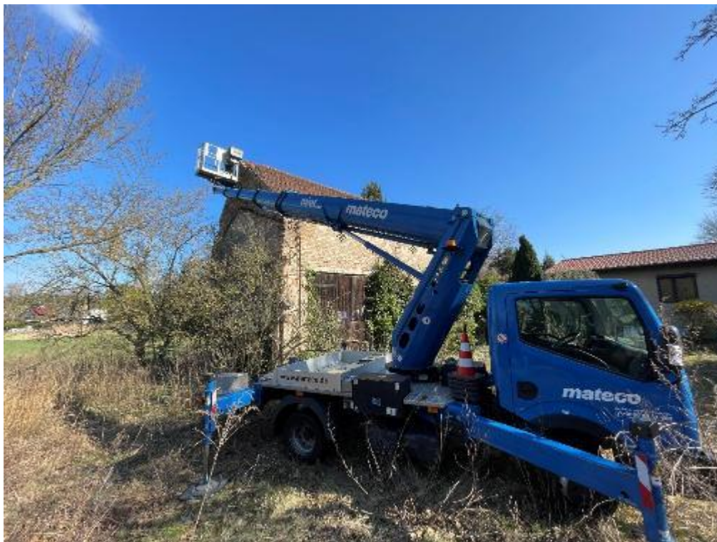
Abbildung 11: Einsatz der Hebebühne an den Gebäuden
