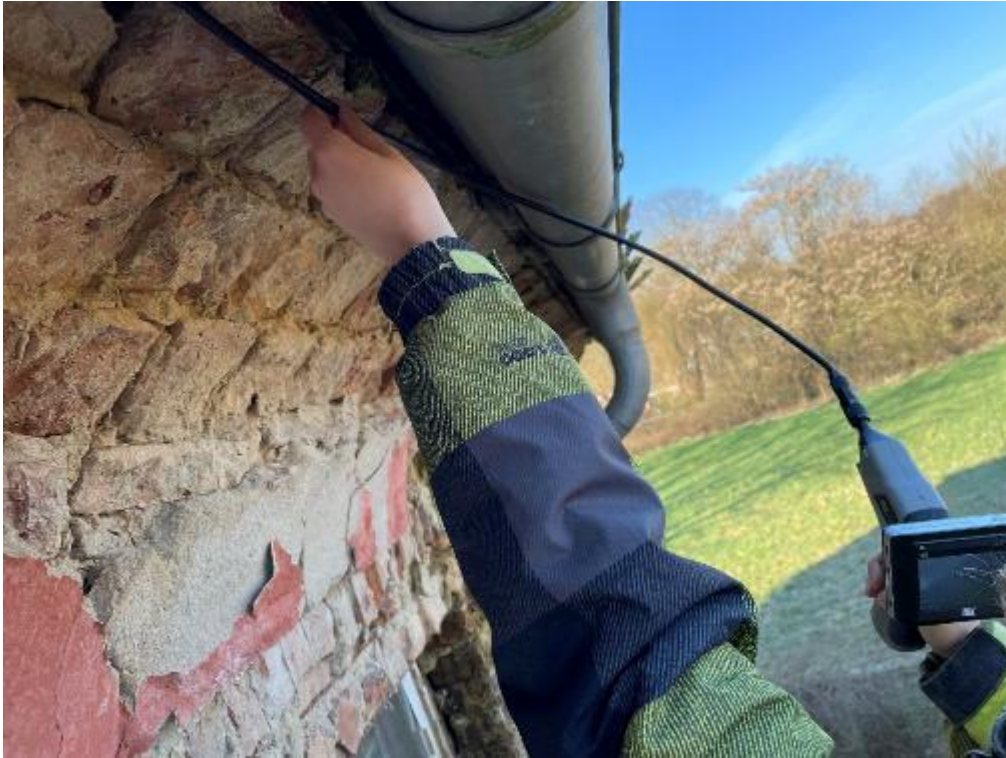
Abbildung 12: Spalten am Gebäude werden per Endoskop untersucht
