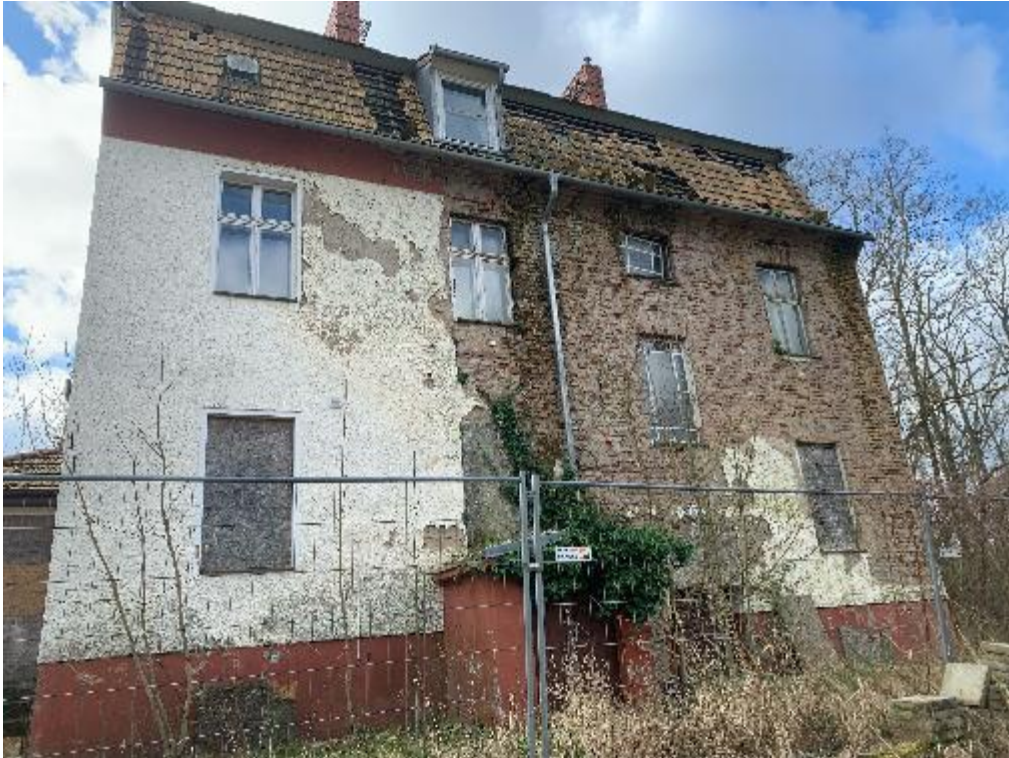
Abbildung 6: Blick auf das Abrissgebäude, ehemals Wohnhaus, Bild vom 19.3.2024
