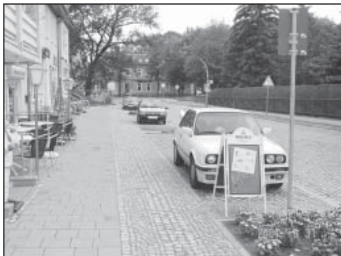
Neuer Gehweg und Parktaschen in der Goethestraße zwischen ehemaliger Post und Goethebogen fertiggestellt
