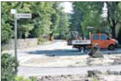
Die Bagger sind mittlerweile vom Dorfanger in Zeuthen Miersdorf verschwunden. Die Bauarbeiten an der L402 verliefen planmäßig und reibungslos.
