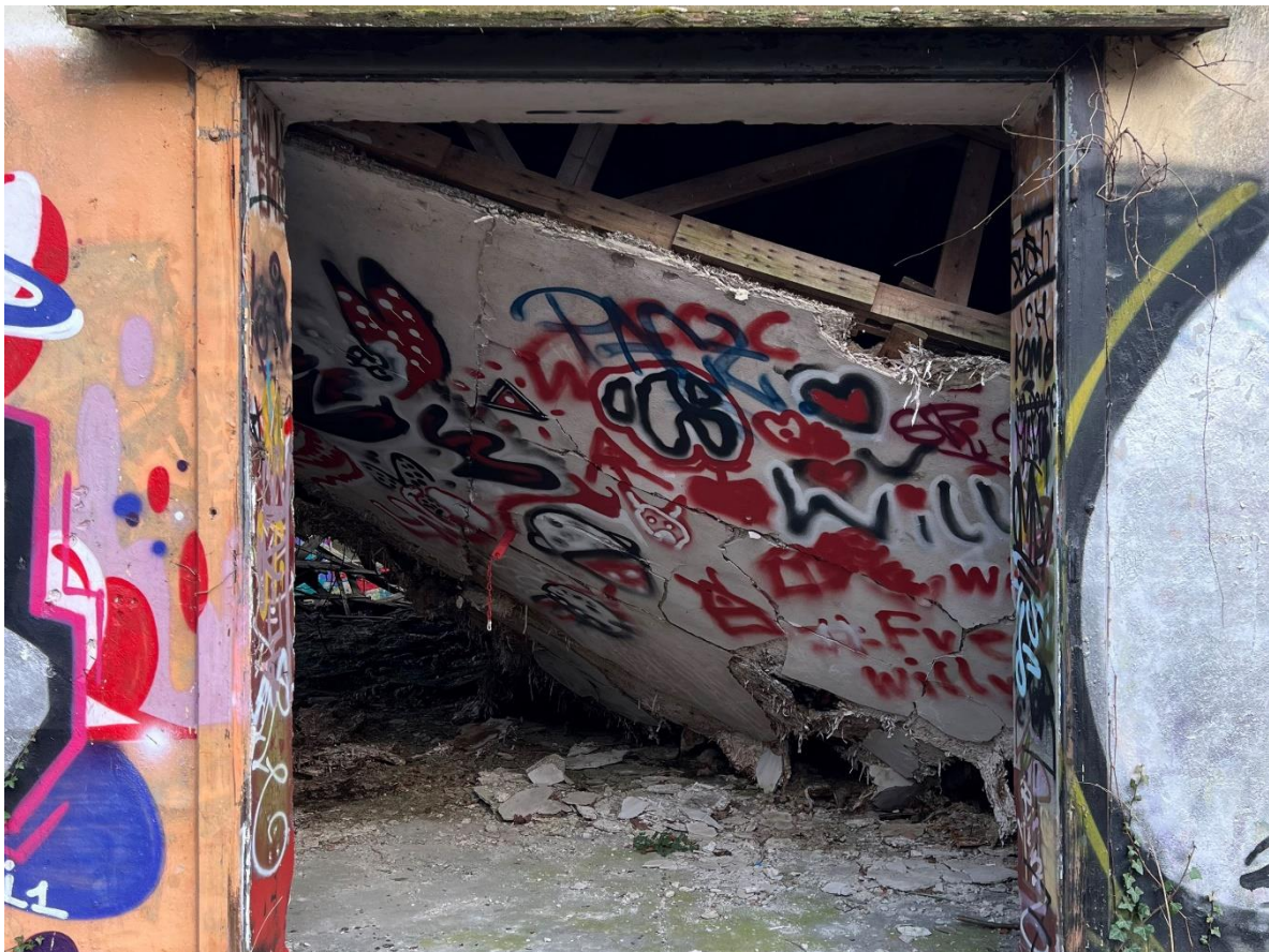
Abbildung 5: Aktueller Ist-Zustand auf den Flurstücken 25/1 und 29/1. Einblick in einer der alten Gewerbehallen.
