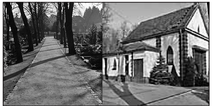
Neuer Gehweg fertiggestellt Pflasterfläche an der Trauerhalle
