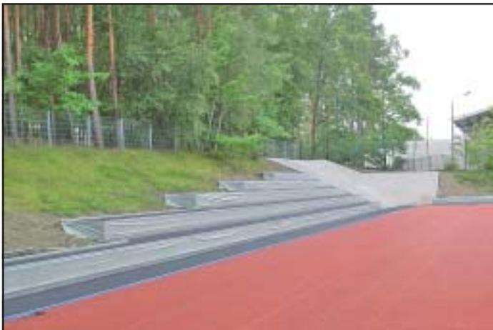
ab. An der Westseite des Spielfeldes wird die Böschung ebenfalls durch Betonwinkel aufgefangen, so dass künftig nicht mehr bei jedem Regen Sand bzw. Erde auf die Spielflächen gespült wird.
