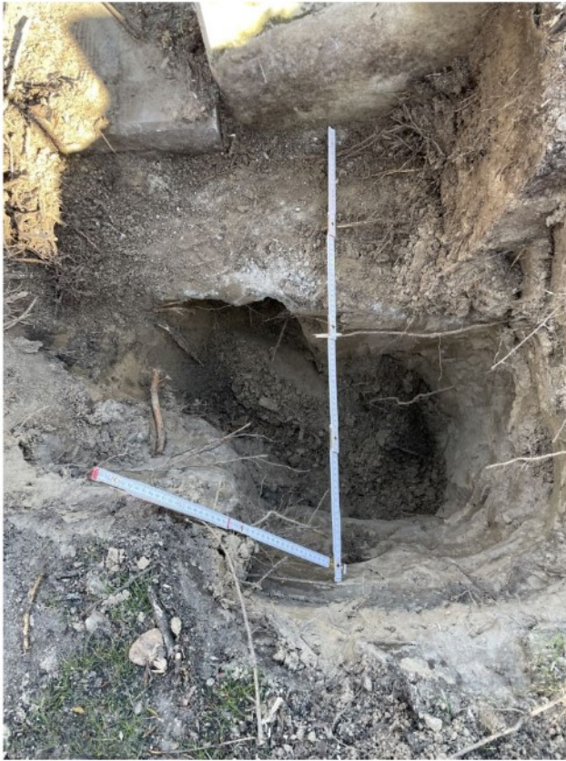
Bild 28: Suchgraben 5, mit lediglich vorgefundenen Schwach- und Feinwurzeln
