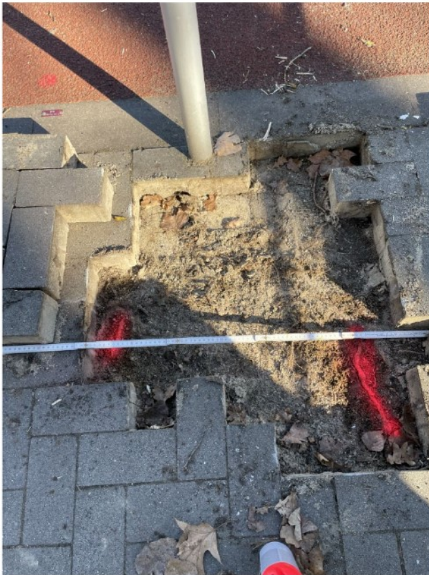
Bild 30: Suchgraben 6, mit zwei 2cm starken Grobwurzeln
