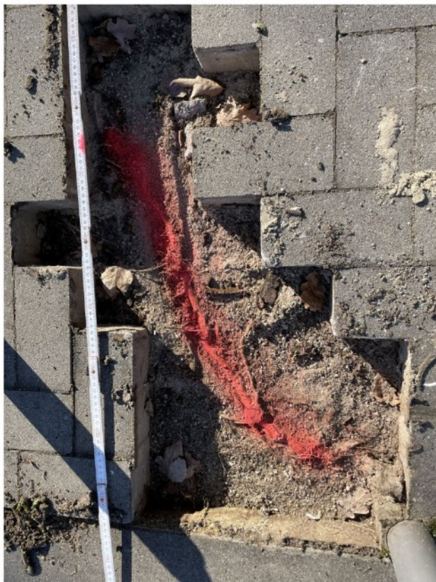
Bild 26: Suchgraben 4, vorgefundene 4cm starke Grobwurzel
