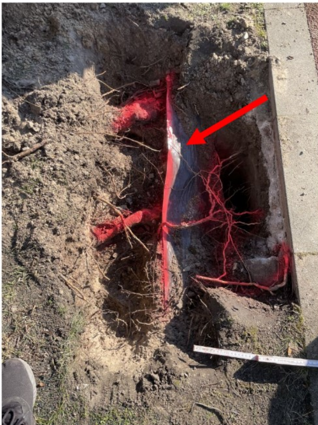
Bild 53: Suchgraben 15, mit einer 10cm und einer 6cm starken Starkwurzel und einer Wurzelschutzfolie
