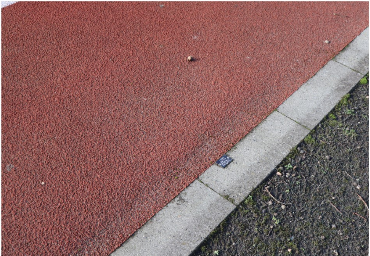
Bild 8: durch Wurzeleinwuchs verursachte Hebung der Laufbahn im Randbereich der östlichen Laufbahngerade mit teilweisen Aufbrüchen
