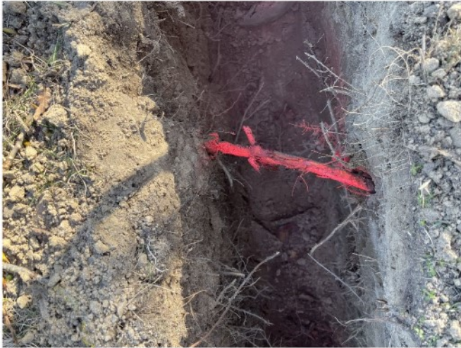
Bild 34: Suchgraben 7, mit einer 2cm starken Grobwurzel und ohne erkennbare Wurzelschutzfolie
