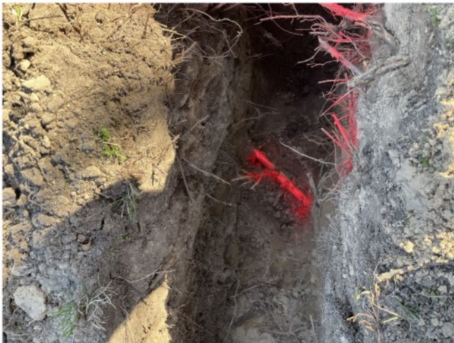
Bild 35: Suchgraben 7, mit einer 2cm starken Grobwurzel
