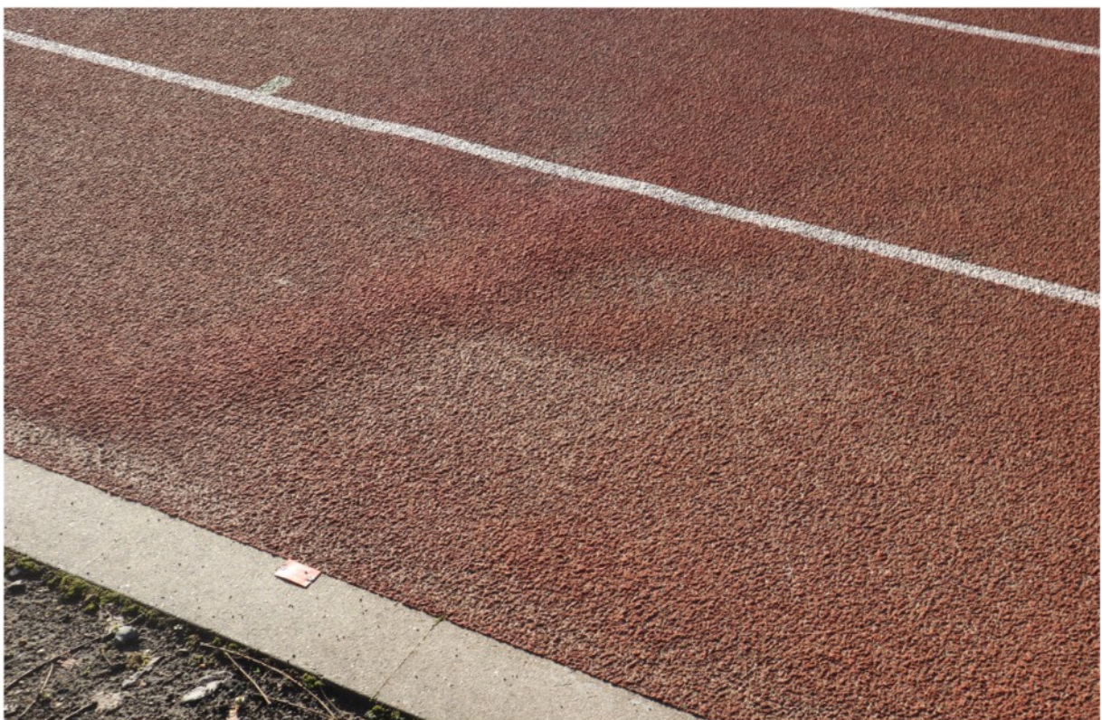
Bild 9: durch Wurzeleinwuchs verursachte Hebung der Laufbahn im Randbereich der östlichen Laufbahngerade mit teilweisen Aufbrüchen
