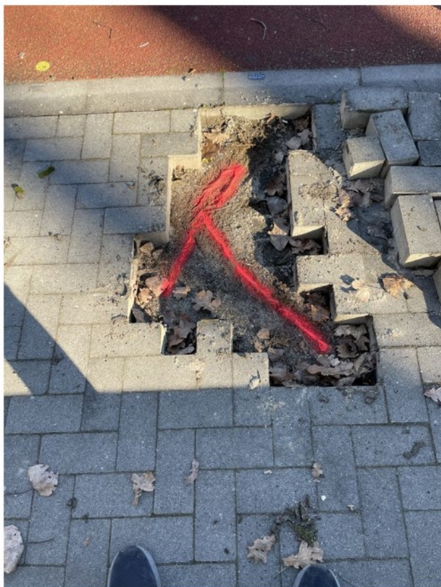
Bild 36: Suchgraben 8, mit einer 2cm starken Grobwurzel
