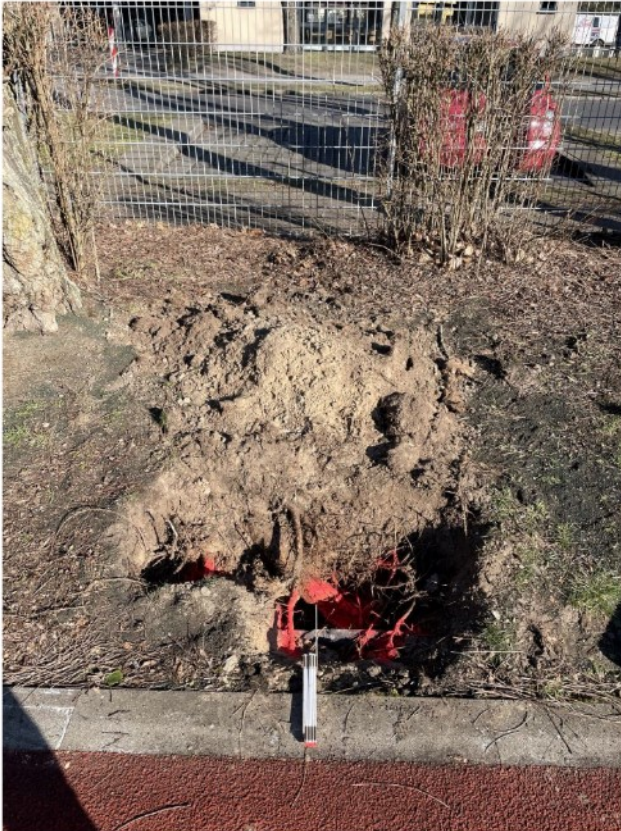
Bild 46: Suchgraben 13, mit einer Wurzelschutzfolie in 30cm Entfernung zur Laufbahn
