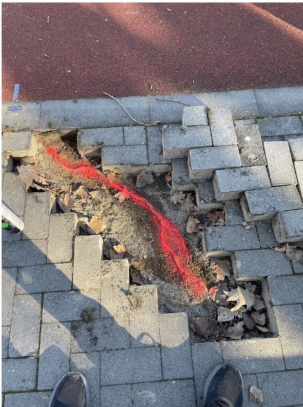
Bild 41: Suchgraben 11, mit einer 2cm starken Grobwurzel
