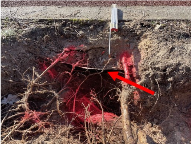
Bild 48: Suchgraben 13, mit einer Wurzelschutzfolie in 20cm Tiefe
