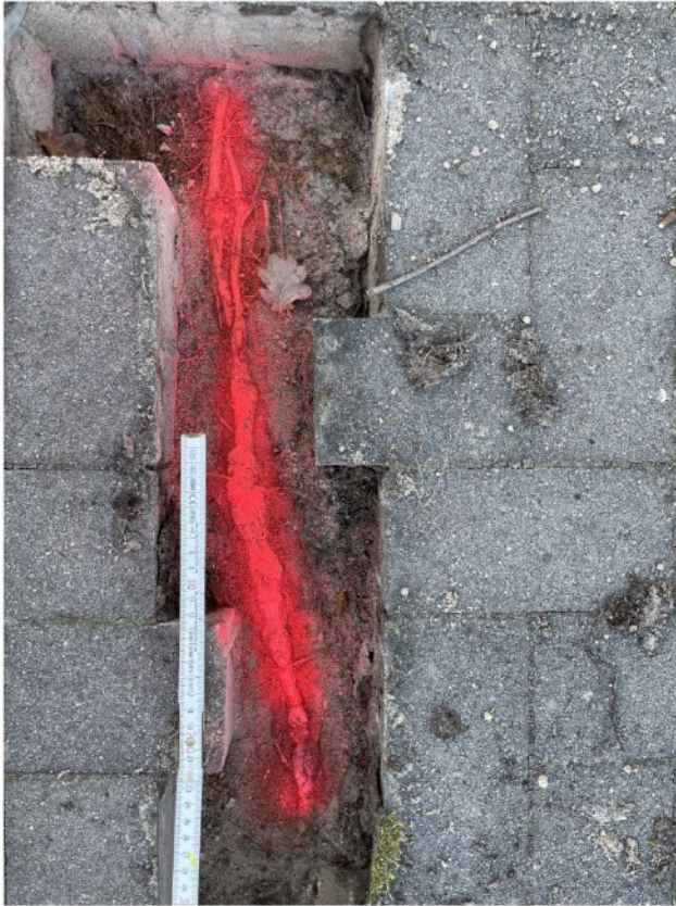
Bild 18: Suchgraben 1 (östliche Seite), 3cm starke Grobwurzel
