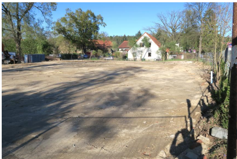
Abb.: Blick von Südwesten auf das Grundstück Dorfstraße 35 nach Verfüllung und Einebnung (April 2026)
