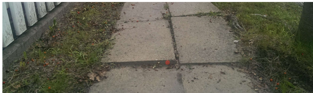
Fotos: Deutsche Tiefbauberatung
