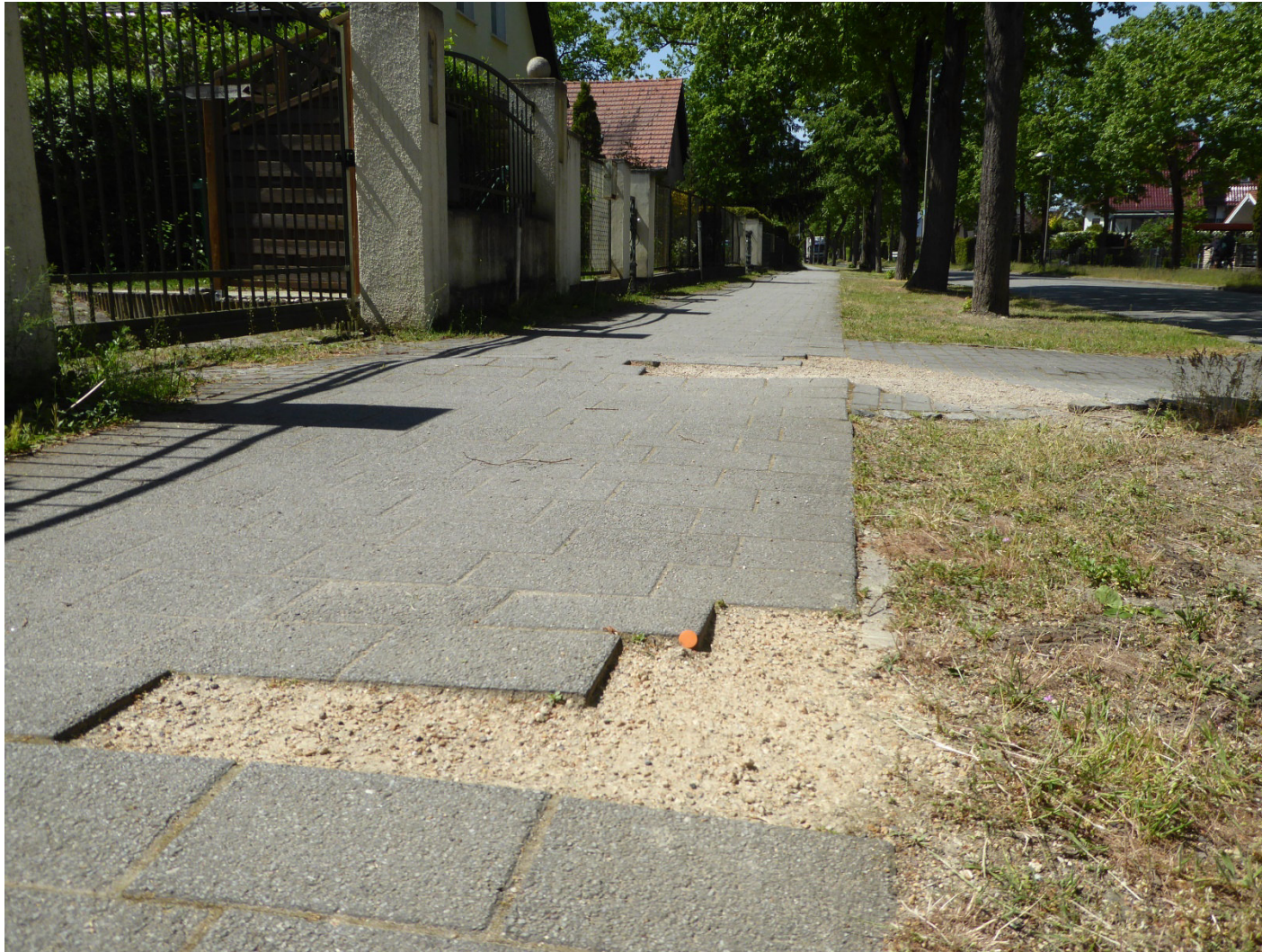
Foto: Deutsche Tiefbauberatung
