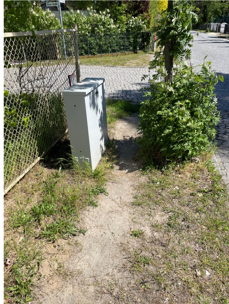
Foto: Deutsche Tiefbauberatung
