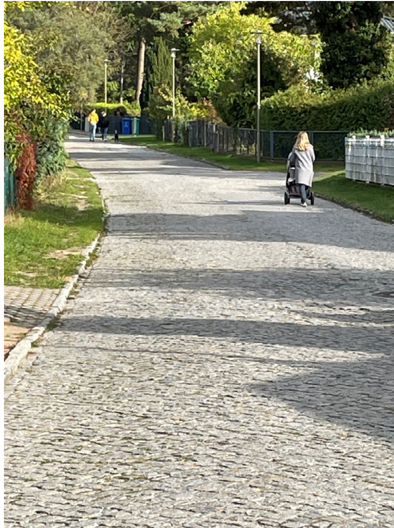
Foto: Deutsche Tiefbauberatung
