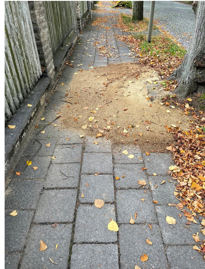
Fotos: Deutsche Tiefbauberatung
