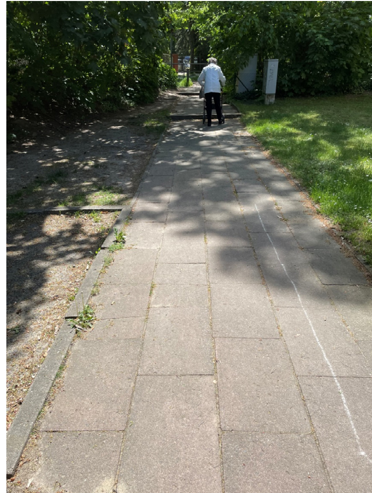
Foto: Deutsche Tiefbauberatung
