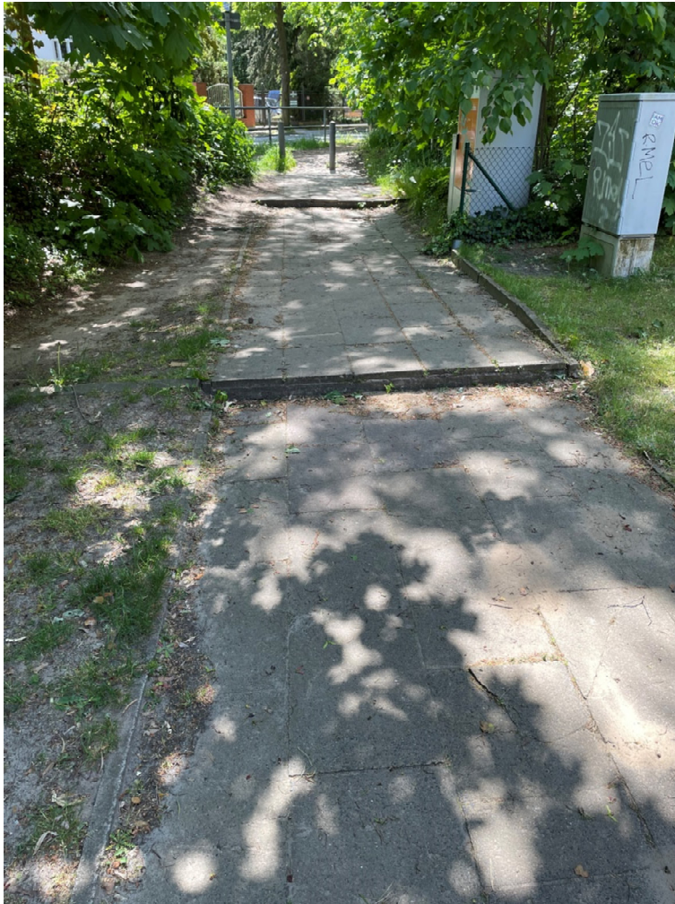
Foto: Deutsche Tiefbauberatung
