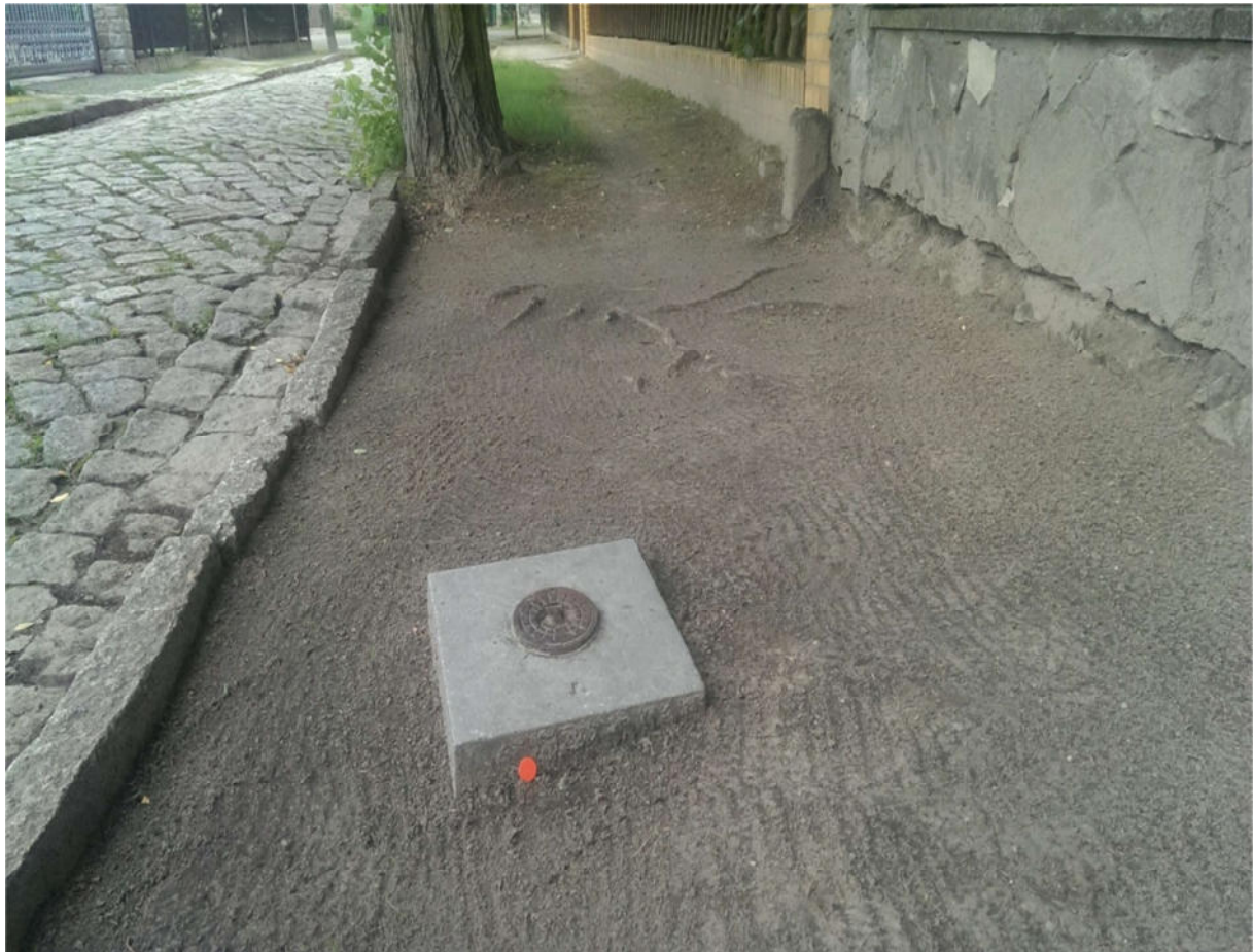
Abb. 27: Freigelegter Wasserschieber im Gehwegsbereich
