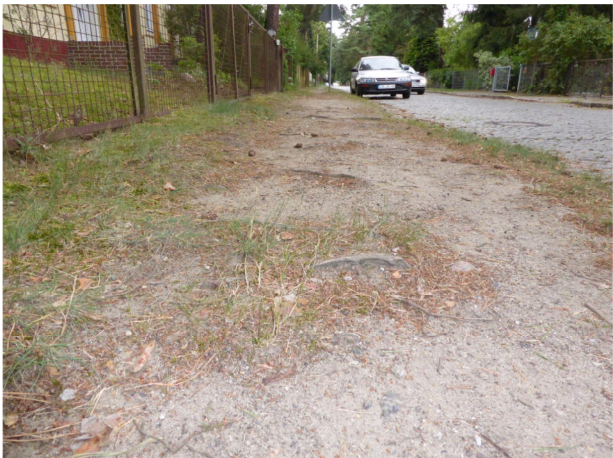
Abb. 19: Unbefestigter Gehweg im Seitenraum einer Straße mit einer Fahrbahn aus Naturstein-Großpflaster
