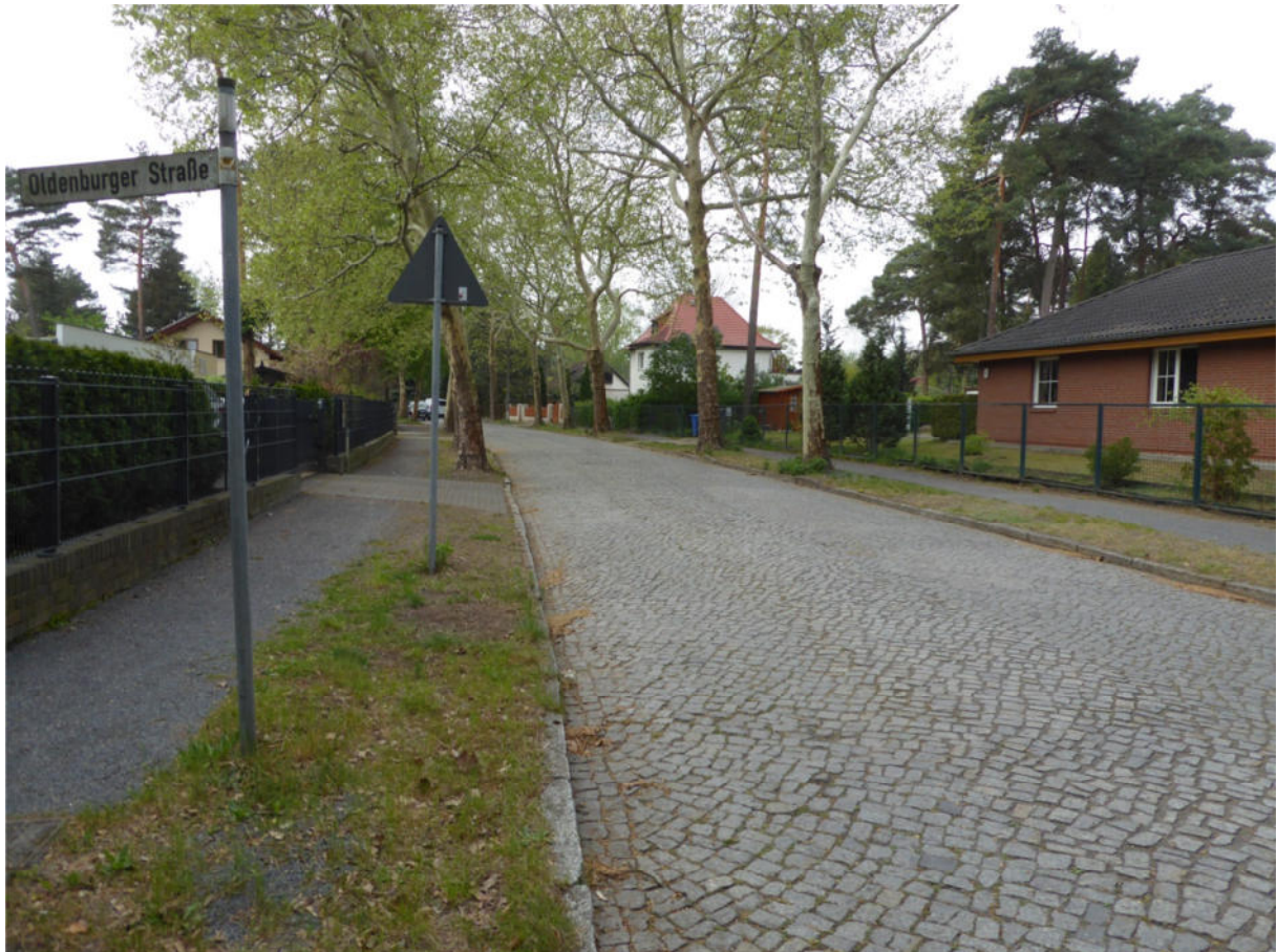
Abb. 13: Bessere Nutzbarkeit der Gehwege durch Sand-Splitt-Gemisch in der Bremer Straße
