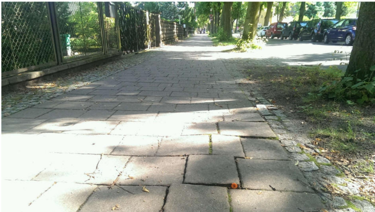
Abb. 24: Plattenhebungen durch Baumwurzeln
