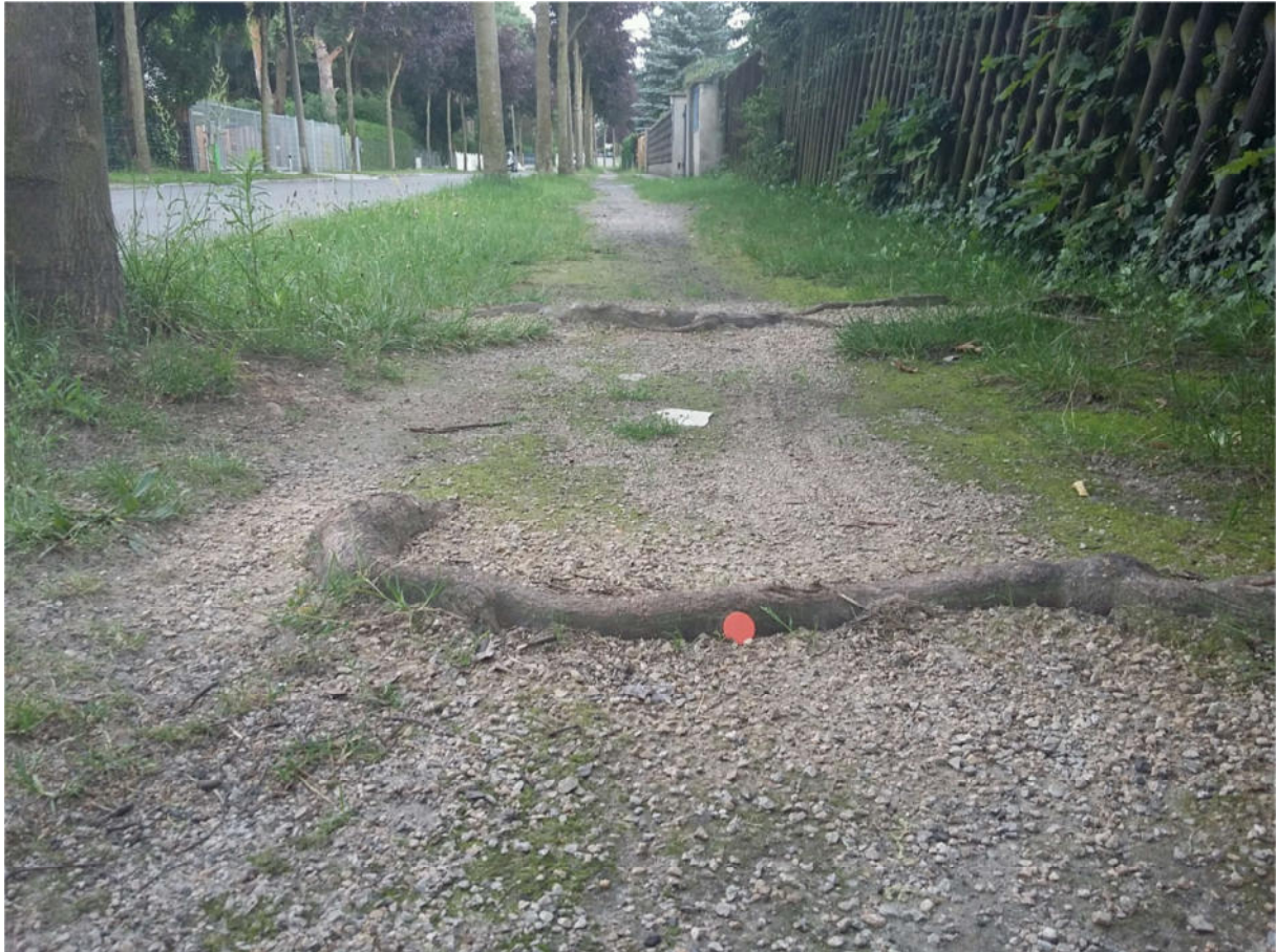
Abb. 22: Unbefestigte Gehwege mit altem Baumbestand
