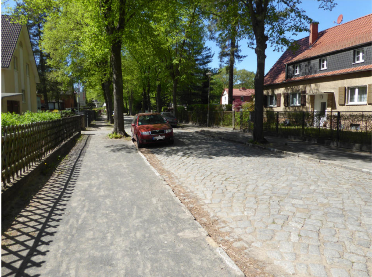
Abb. 31: Profilierung und Befestigung der Gehwege durch ein Sand-Splitt-Gemisch in der Moselstraße
