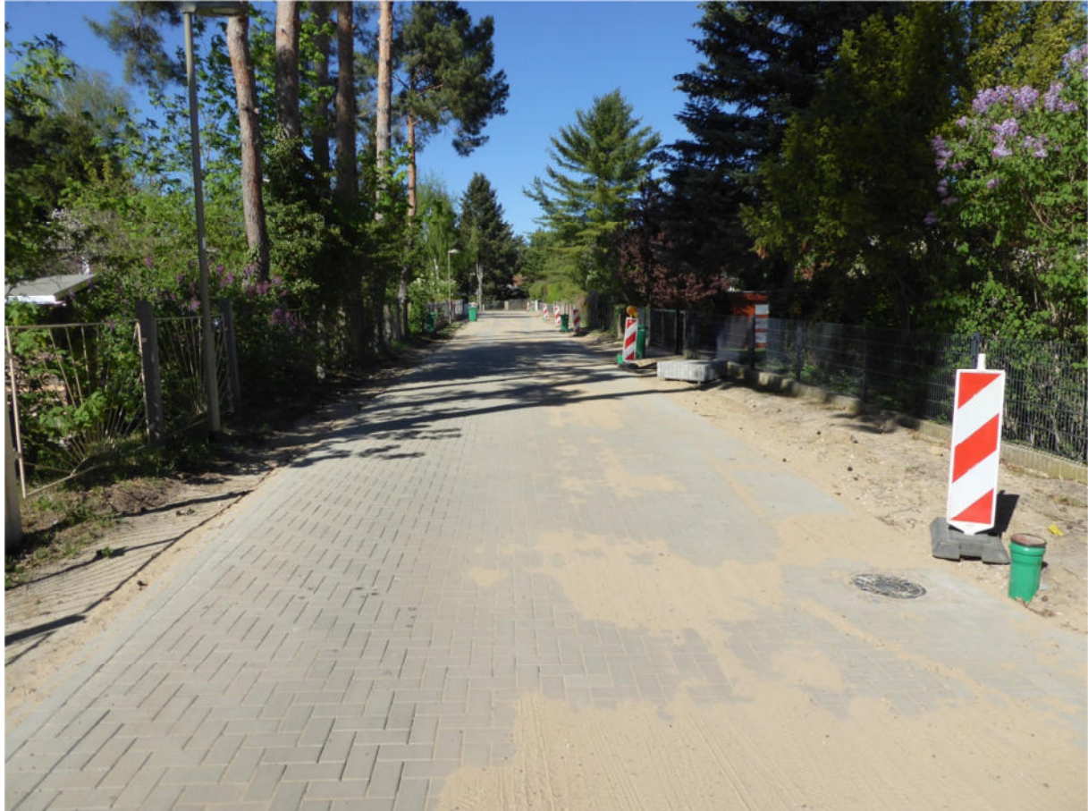
Abb. 20: Neubau einer Mischverkehrsfläche in der Kurzen Straße
