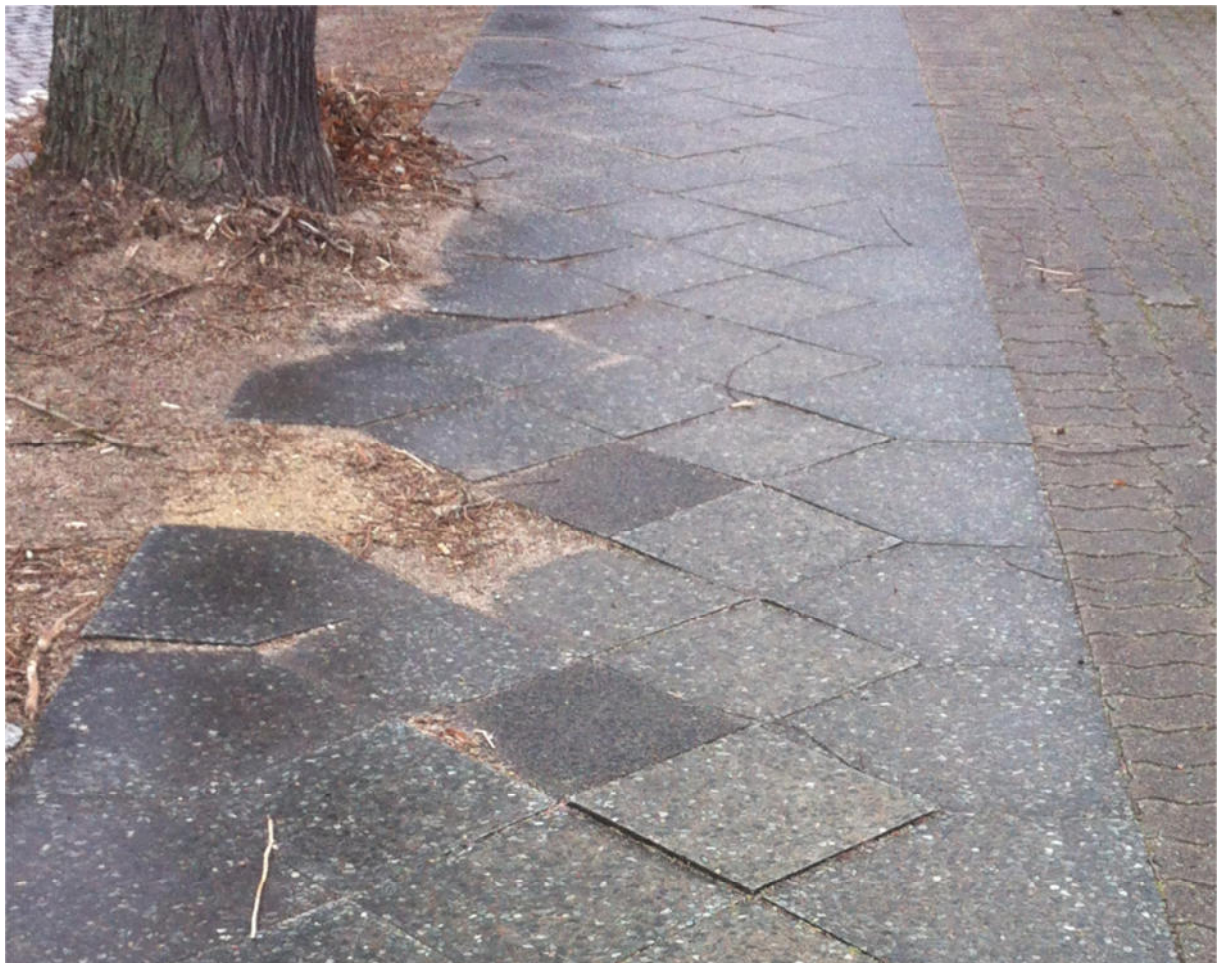
Abb. 21: Beispielhafte Abbildung von Gehwegschäden durch Baumwurzeln
