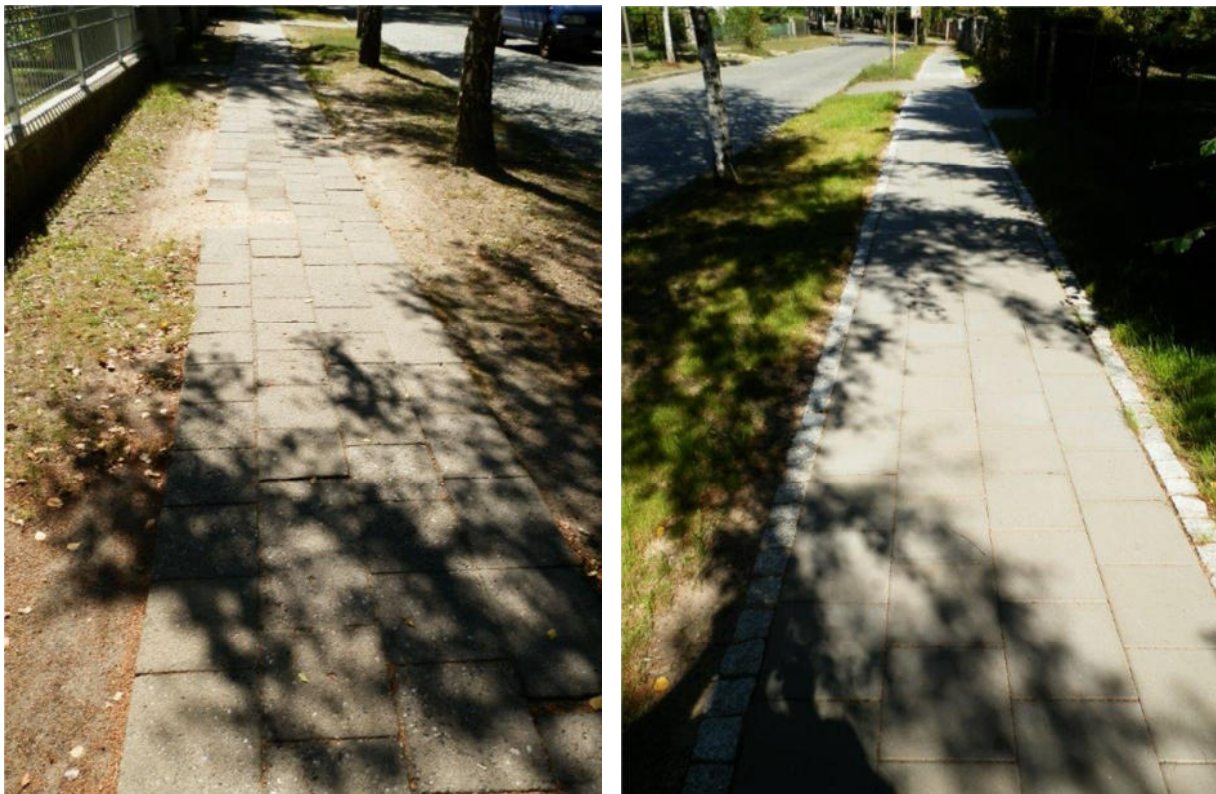
Abb. 30: Alte Gehwegbefestigung (links) und neue Gehwegbefestigung nach abschnittweiser Erneuerung (rechts)
