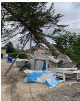
Sturmschaden in Zeuthen
