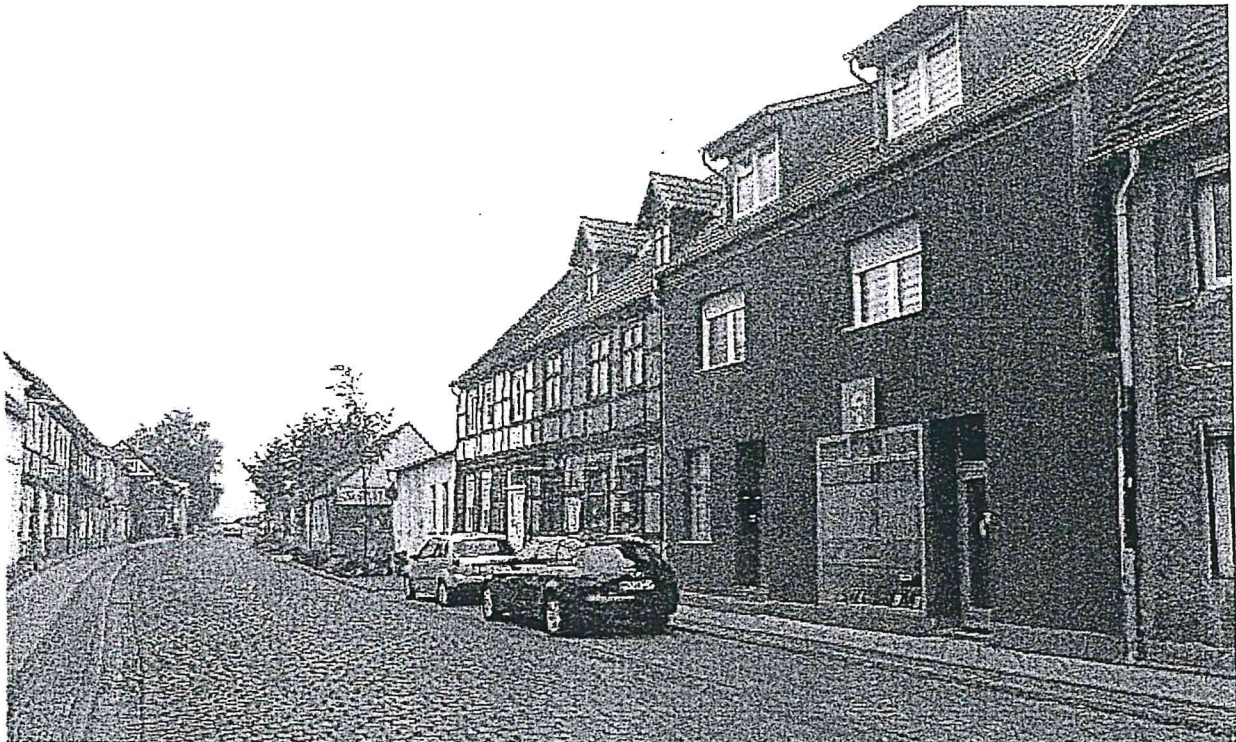
Abbildung 3: In den städtebaulichen Kontext eingegliedert Neubau im Geltungsbereich einer Erhaltungssatzung in Wittenberge
