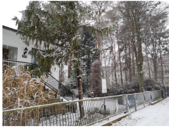
Abb. 12: Bestehendes älteres Wohngebäude (Doppelhaus) im Bungalow-Stil
