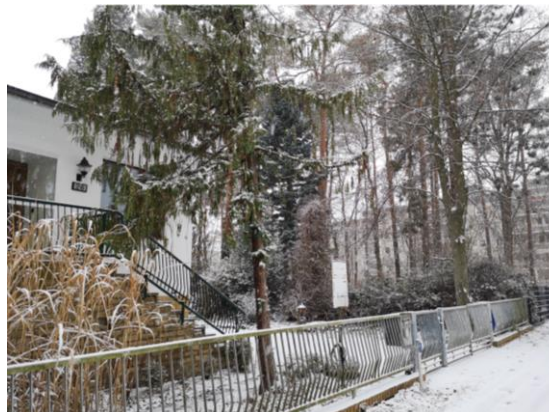
Abb. 12: Bestehendes älteres Wohngebäude (Doppelhaus) im Bungalow-Stil
